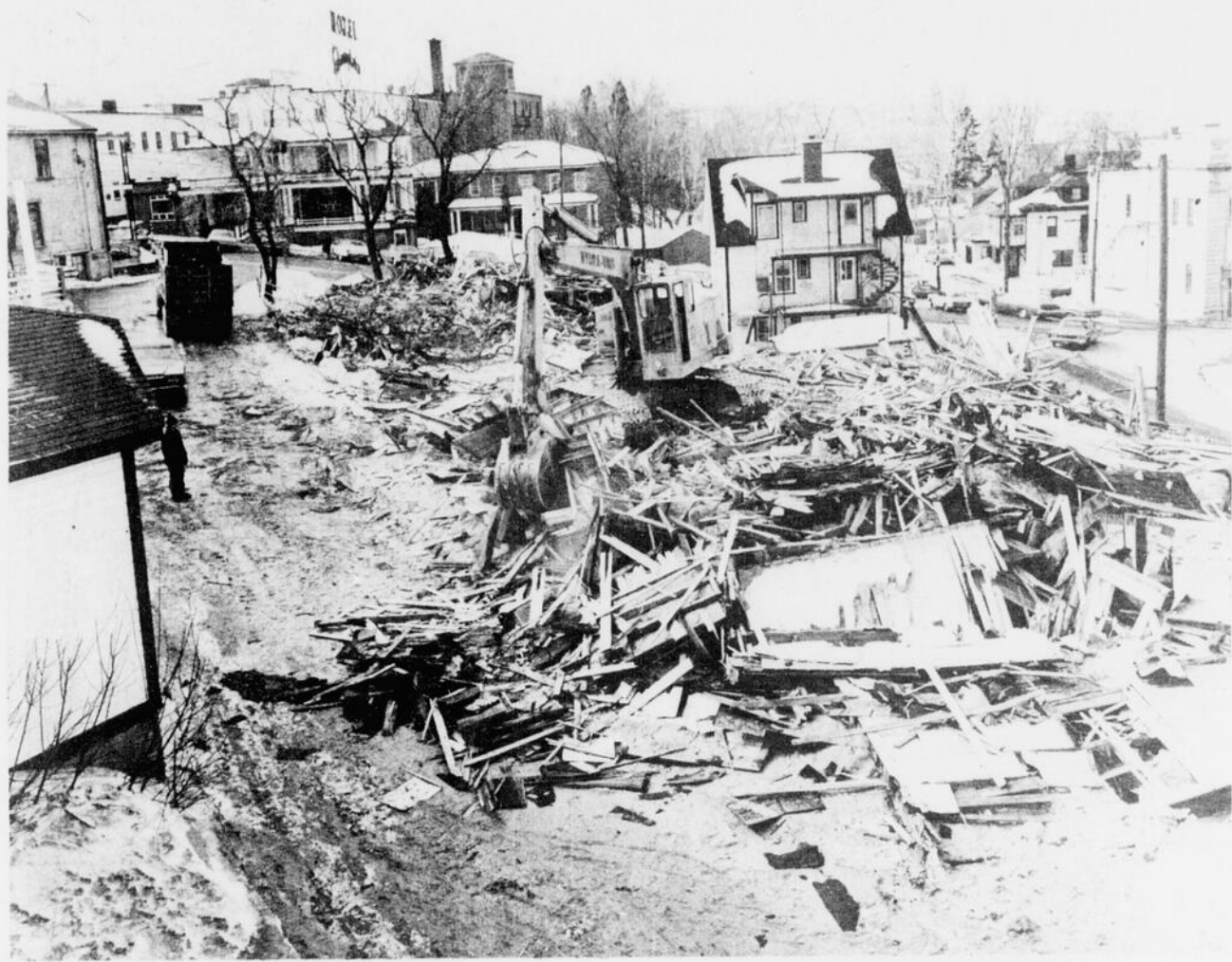
DEMOLITION — Les quelques maisons sises à l'intersection des rues Labrecque et Hôtel-Dieu à Chicoutimi sont présentement les victimes du pic
