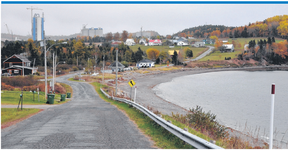
Dans la magnifique anse McInnis, on peut apercevoir l'immense structure de la cimenterie, présentement en construction. (Photo TC Media - Alain Lavoie)
