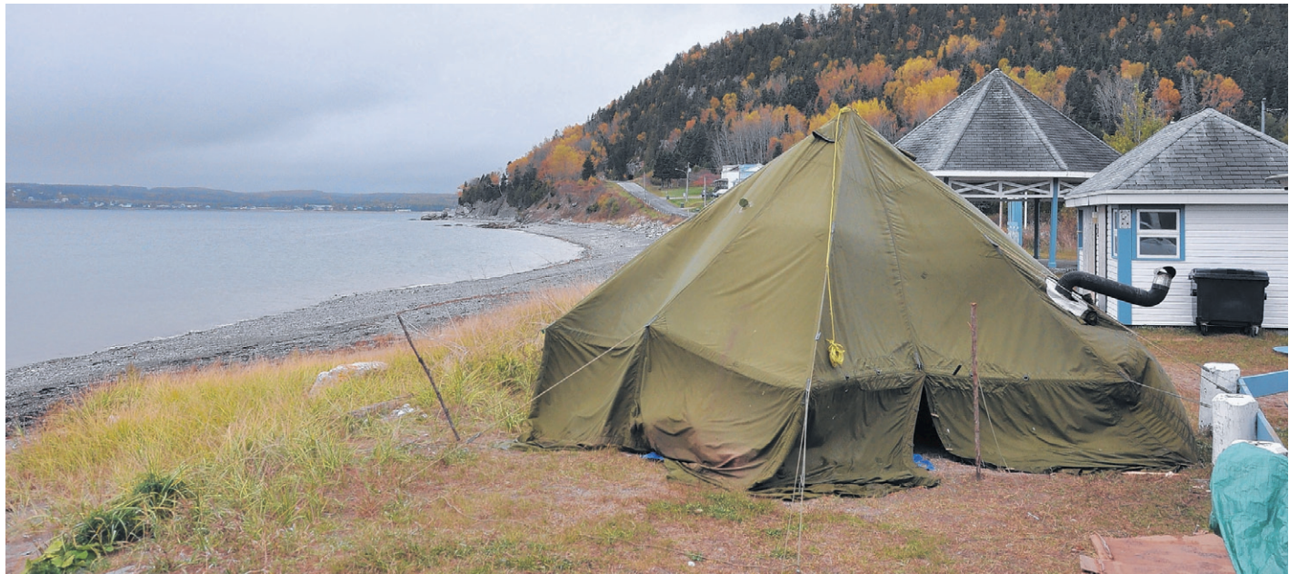
Les environnementalistes d'EVP ont modifié leur stratégie la semaine dernière afin d'être beaucoup plus dans le « trafic », sur le chantier de construction de la cimenterie. (Photo TC Media – Alain Lavoie)
