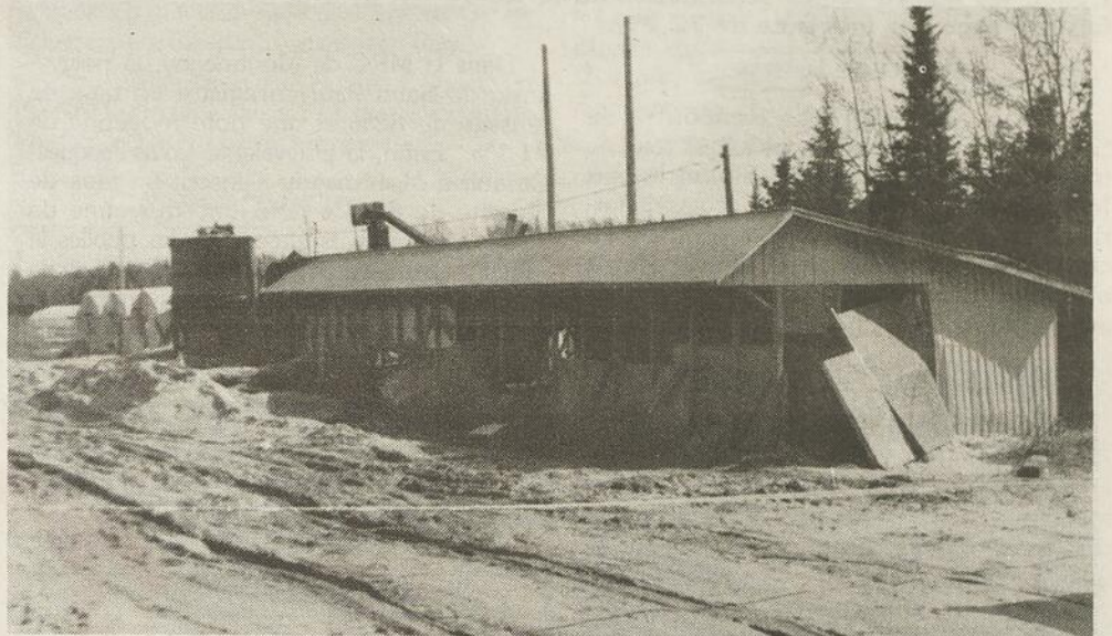
Le feu a détruit la bâtisse abritant le système de chauffage des Pépinières Saint-Marcel.
