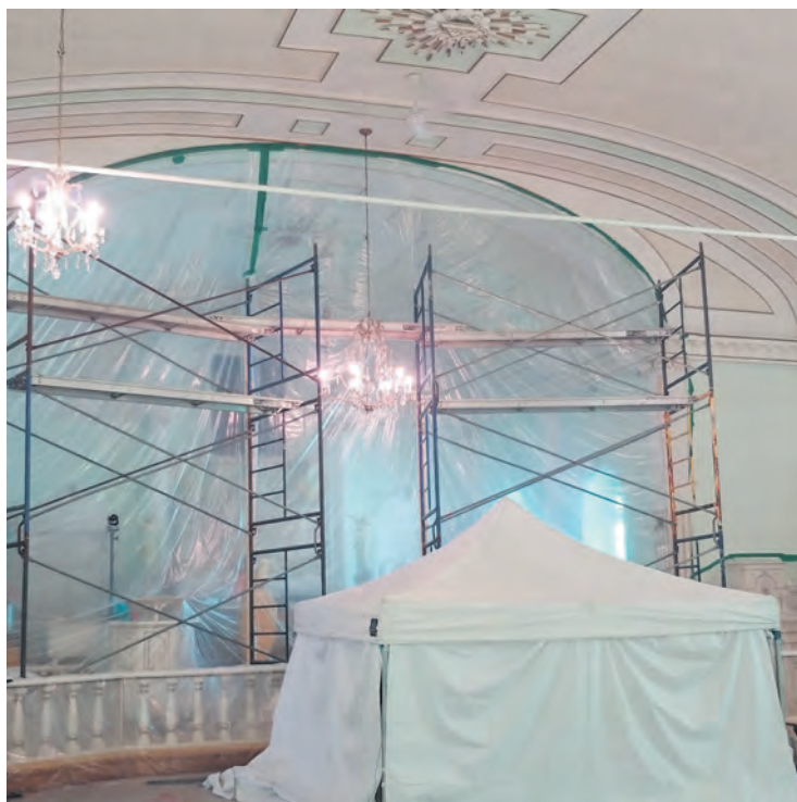
Les travaux ont commencé en début mars.
