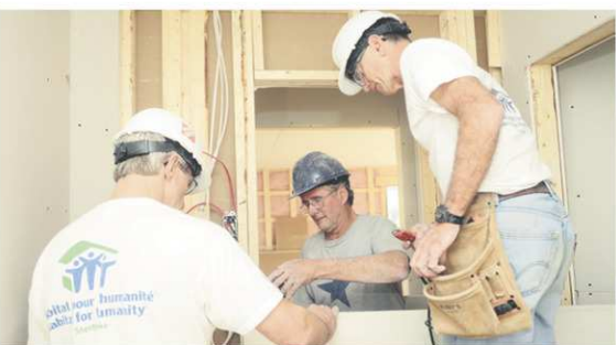
La construction de la maison de la famille Martin-Tessier va bon train. Elle sera terminée le 15 décembre grâce au travail de la famille et d'environ 75 bénévoles qui ont participé en donnant de leur temps.
