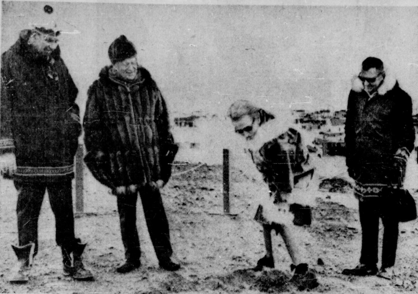
(Téléphoto PC) M. ET MME MICHENER A FROBISHER BAY — Mme Roland Michener, l'épouse du gouverneur général du Canada, a levé une première pelletée de terre pour souligner un nouveau projet qui comprendra un centre commercial et récréatif, ainsi qu'une école et un centre d'habitation, à Frobisher Bay, Territoires du Nord-Ouest. On voit à l'extrême gauche, M. S.M. Hodgson, commissaire des Territoires du Nord-Ouest, et M. Michener. A droite, on voit M. Alec Fellow, président de la compagnie Frobisher Developments Ltd.
