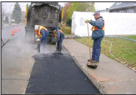
Réparation par l'arrondissement St-Hubert, Ville de Longueuil
