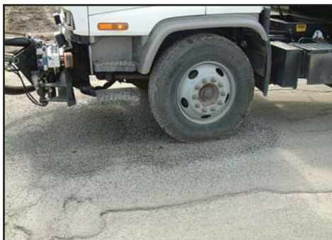
Figure 4 – Compaction des matériaux avec la roue du camion
