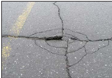
Figure 2 – Formation d'un nid-de-poule
