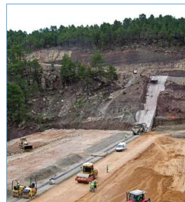
Construction du barrage Mora de Rubielos en Espagne.
