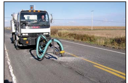
Figure 3 – Véhicule projetant un mélange de granulats et d'émulsion
