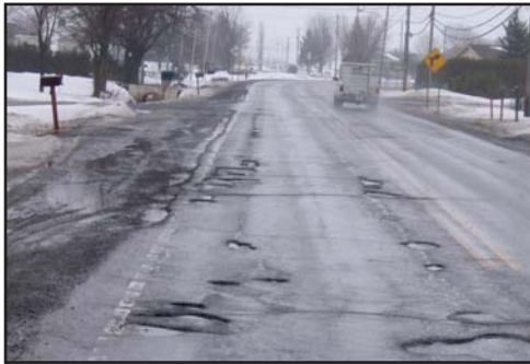
Application typique : pelades de chaussée
