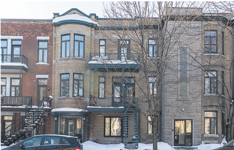
Le condo est situé au troisième et dernier niveau, auquel on accède par un escalier intérieur de cet immeuble datant de 1900. Des plans pour une terrasse sur le toit sont déjà faits et approuvés par la Ville et les copropriétaires. Il est à distance de marche du métro et de nombreux services.
