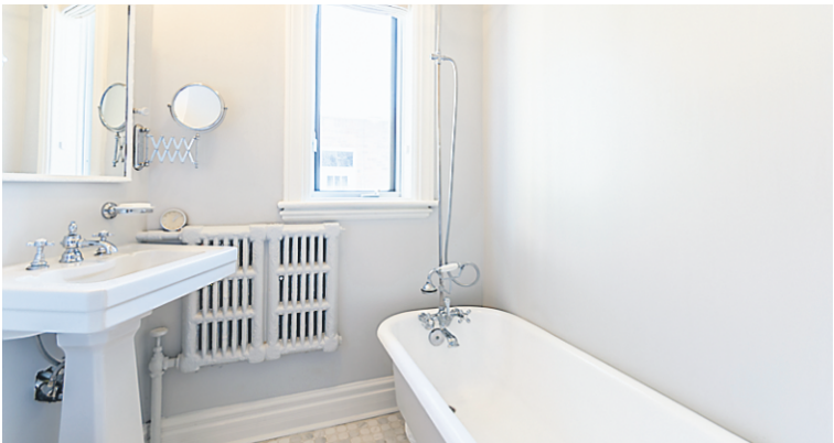
Les propriétaires ont apporté beaucoup de soin à la mise à niveau de leur salle de bains. La baignoire en fonte a eu droit à un ré-émailage complet et à l'ajout d'une robinetterie de très grande qualité qui se marie bien au décor. Le lavabo sur piédestal est une nouvelle acquisition.
