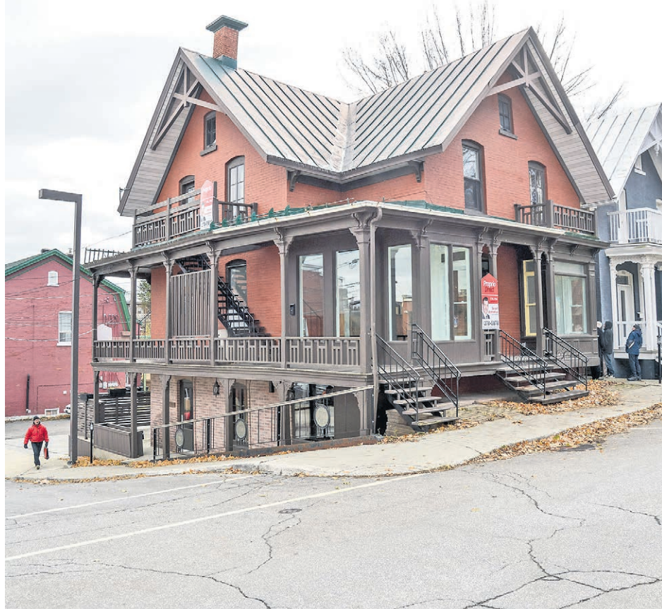
Le parement de brique de la maison du 1805, rue Girouard Ouest a été restauré par Raynald Therrien. Photo François Larivière | Le Courrier ©
