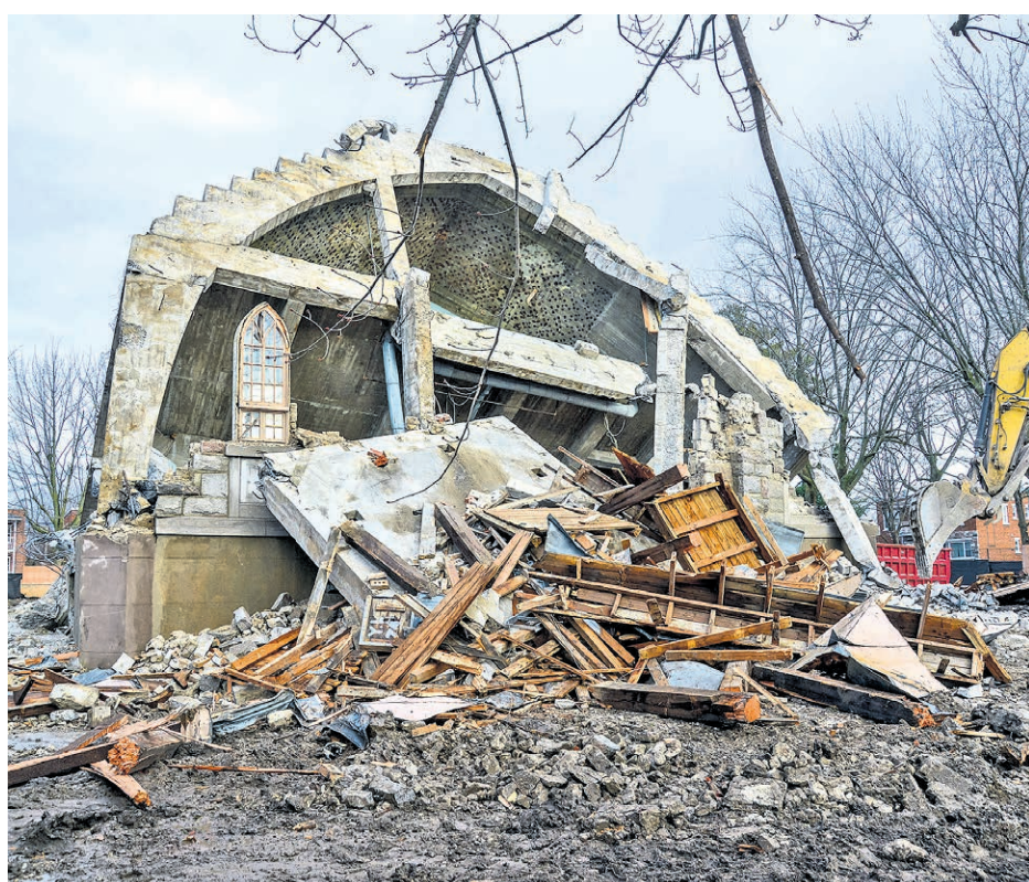
Les travaux de démolition ont progressé rapidement cette semaine. Mercredi après-midi, il ne restait plus grand-chose de l'église Sacré-Coeur-de-Jésus. Photo François Larivière | Le Courrier ©
