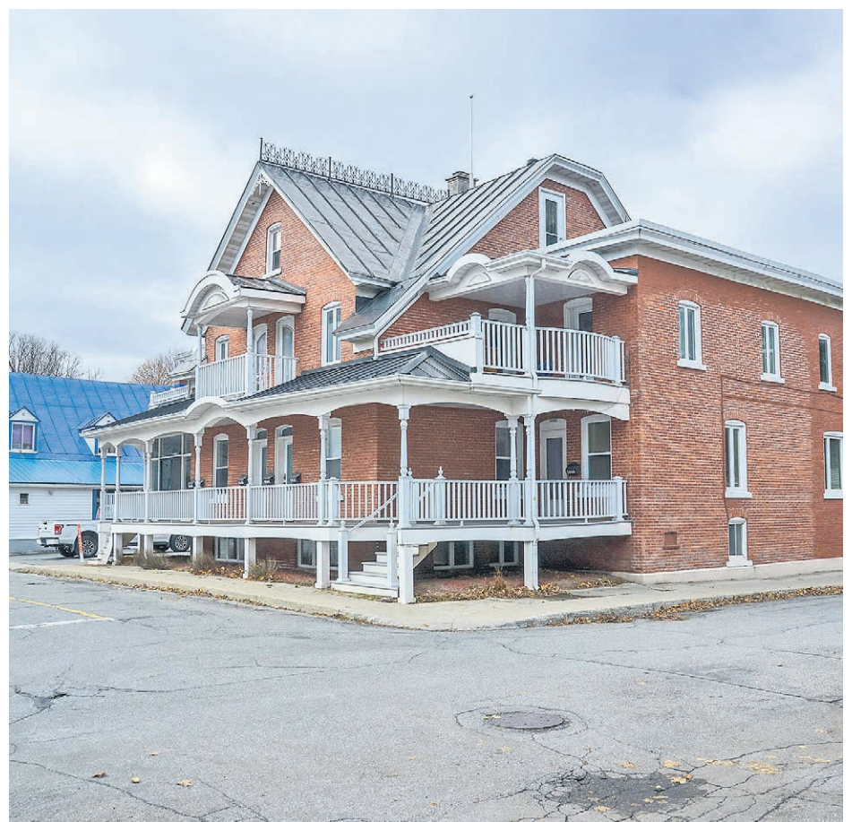
Les murs de brique de la grande maison du 2000, rue Saint-Patrice ont été restaurés par Bertrand Hébert. À gauche, la maison en « pièce sur pièce » de Raynald Therrien. Photo François Larivière | Le Courrier ©
