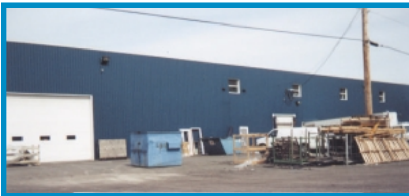
Photo 11. Conteneur pour les résidus industriels et récupération du bois - Sorel-Tracy
