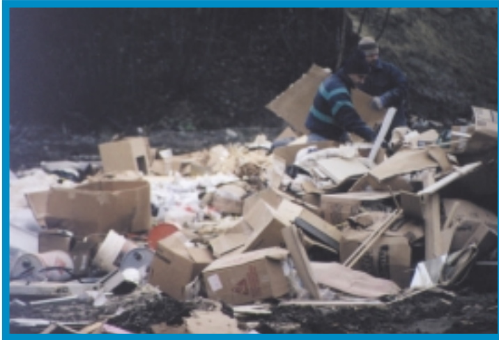
Photo 28. Résidus de construction et de démolition
