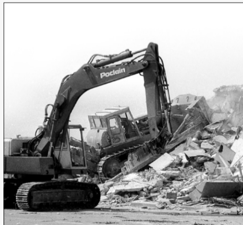
Un Bulldozer détruit une maison du Sinaï en 1982.
