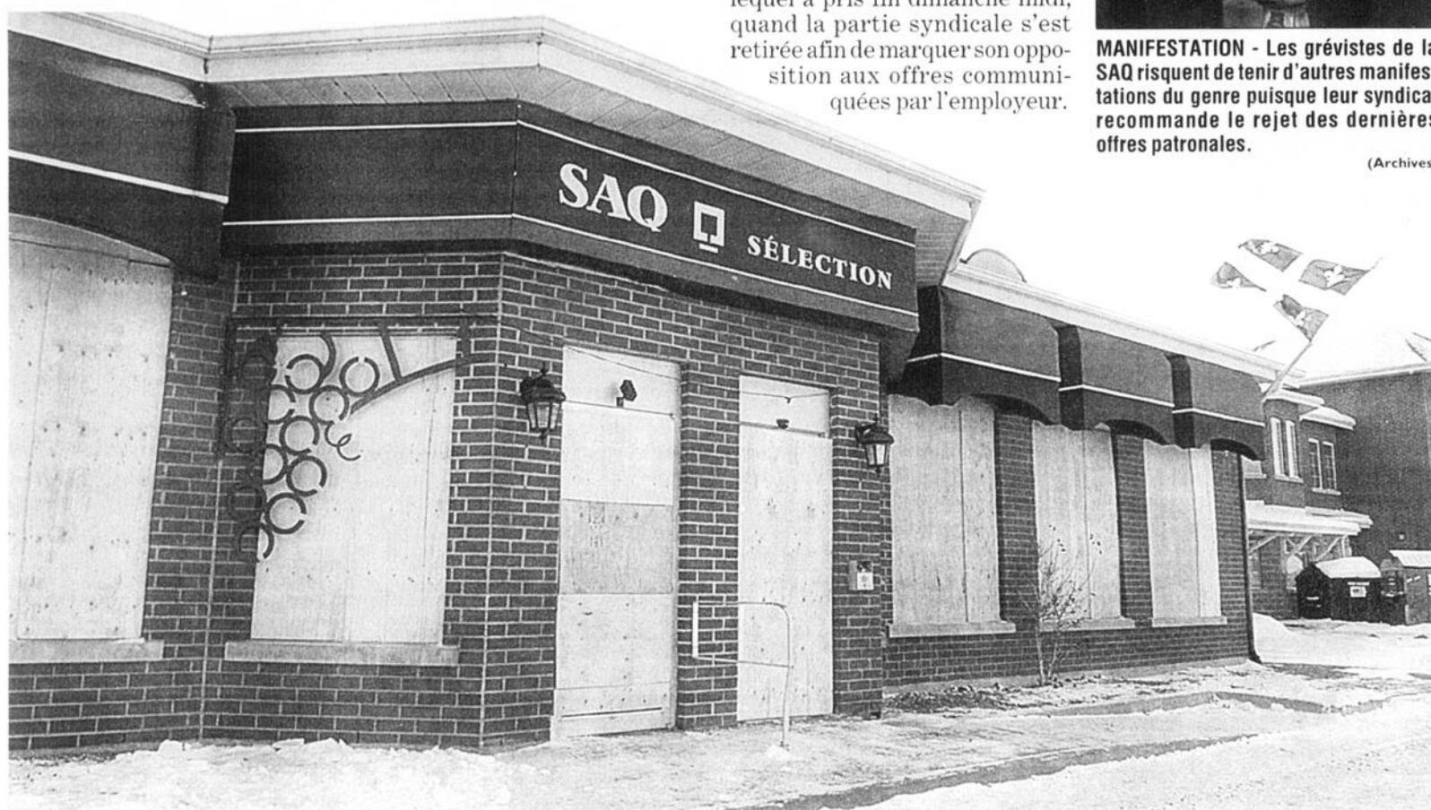
VANDALISME - Ce magasin de la Société des alcools du Québec compte parmi ceux qui ont été la cible d'actes de vandalisme, hier. Il se trouve sur le boulevard Saguenay, à Chicoutimi.
