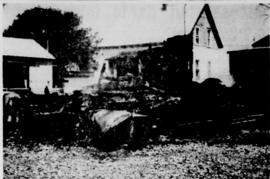
RASEE AU SOL — Un violent incendie a rasé au sol la demeure de M. Joseph Ladouceur, du 119 rue Montfette, à Drummondville-Nord. Le foyer a été signalé aux environs de 11h 30 p.m. samedi soir dernier. Sur la photo, les ruines encore fumantes de la propriété qui a été la proie des flammes.
