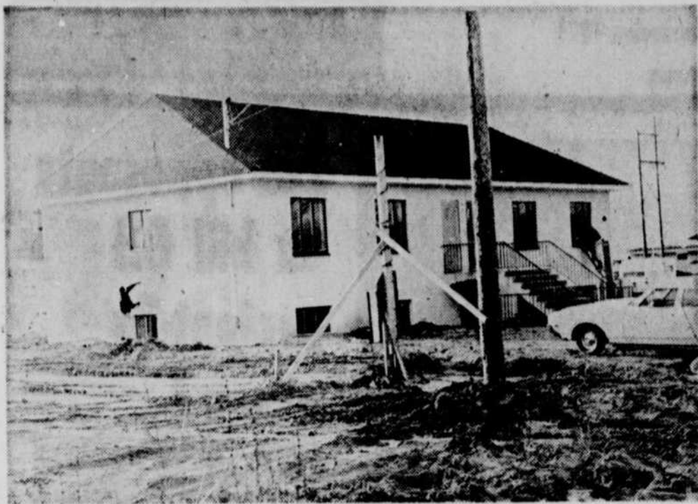
La construction de ce qui deviendra sous peu le poste central de la Sûreté du Québec à Charny est presque complétée. On a ici un aperçu global de ce que sera le nouveau poste d'un étage et demi (sous-sol).
