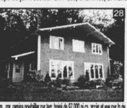
Dom., gar. remise pontable sur terr. boisé de 97,000 pi.ca. accès et vue sur la r.
