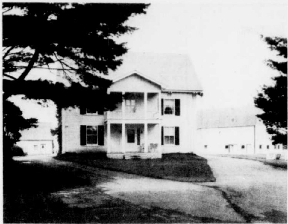
Bien que les deux balcons aient été refaits il y a quelques années, la maison a gardé une fière personnalité.
