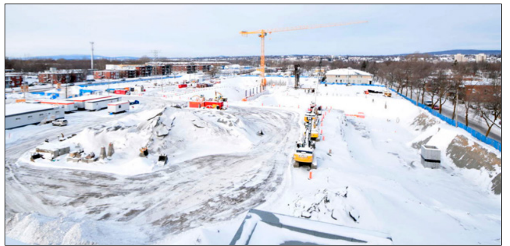
Le chantier du NCH était sous la neige le 5 janvier dernier.
