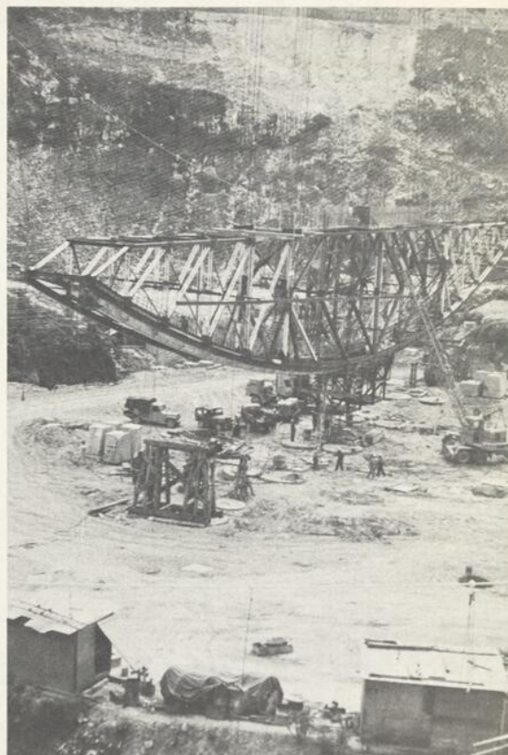
"DÉCOLLAGE" du support de l'antenne focale. Au fond, on aperçoit une partie du réseau des 318 câbles de support courant dans la direction est-ouest. On distingue quelques uns des câbles sud-nord disposés à tous les 100 pieds.
