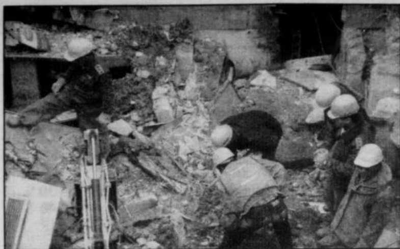
Les équipes de sauveteurs israéliens et arabes ont travaillé toute la matinée dimanche pour trouver des survivants et retirer 23 corps des décombres après la catastrophe survenue à Jérusalem, samedi. Le toit d'un édifice s'est écroulé.
