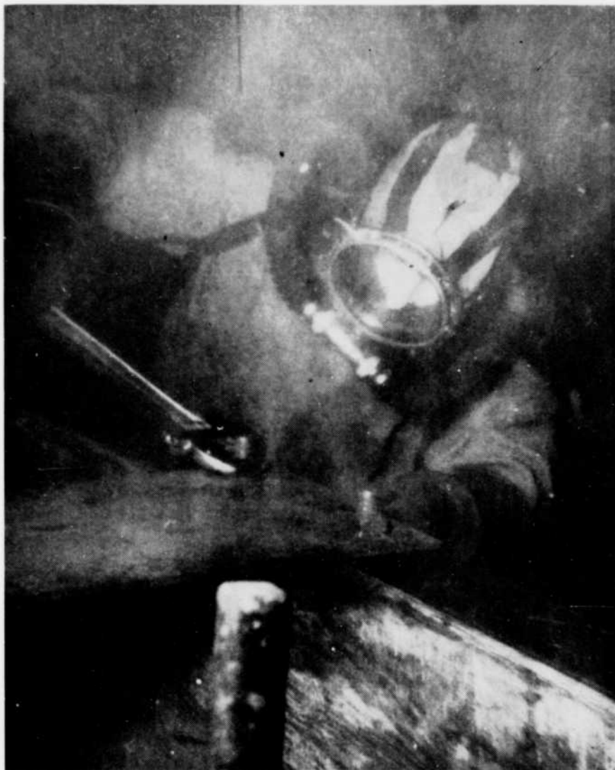
Plongeur en train de serrer un coffrage à la centrale des Cèdres, près de Montréal
