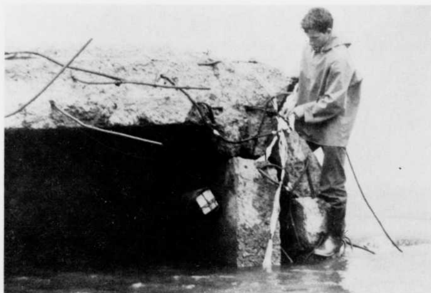
Préparatifs de l'explosion d'un caisson en béton armé coulé près de Québec. Deuxième plus grosse explosion sous-marine du nord de l'Amérique — 25,000 livres de dynamite.
