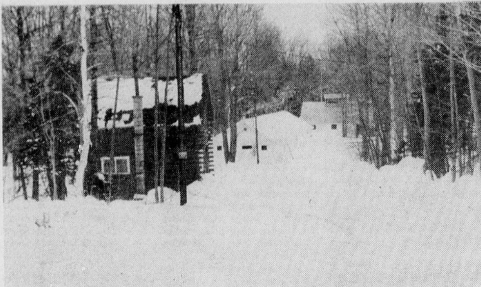
Une vue de installations de l'Erable rouge, située près de St-Donat.
