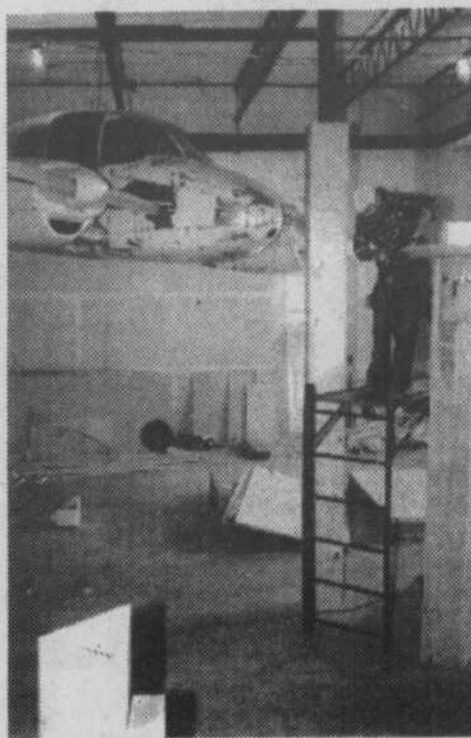
Les travaux de construction de la Cage aux Sports de Lachenaie seront bientôt terminés. Sur la photo, on remarque un imposant avion (un vrai!) qui "survole" une des futures sections de salle à manger. (Texte et photo: Luc Laurin)
