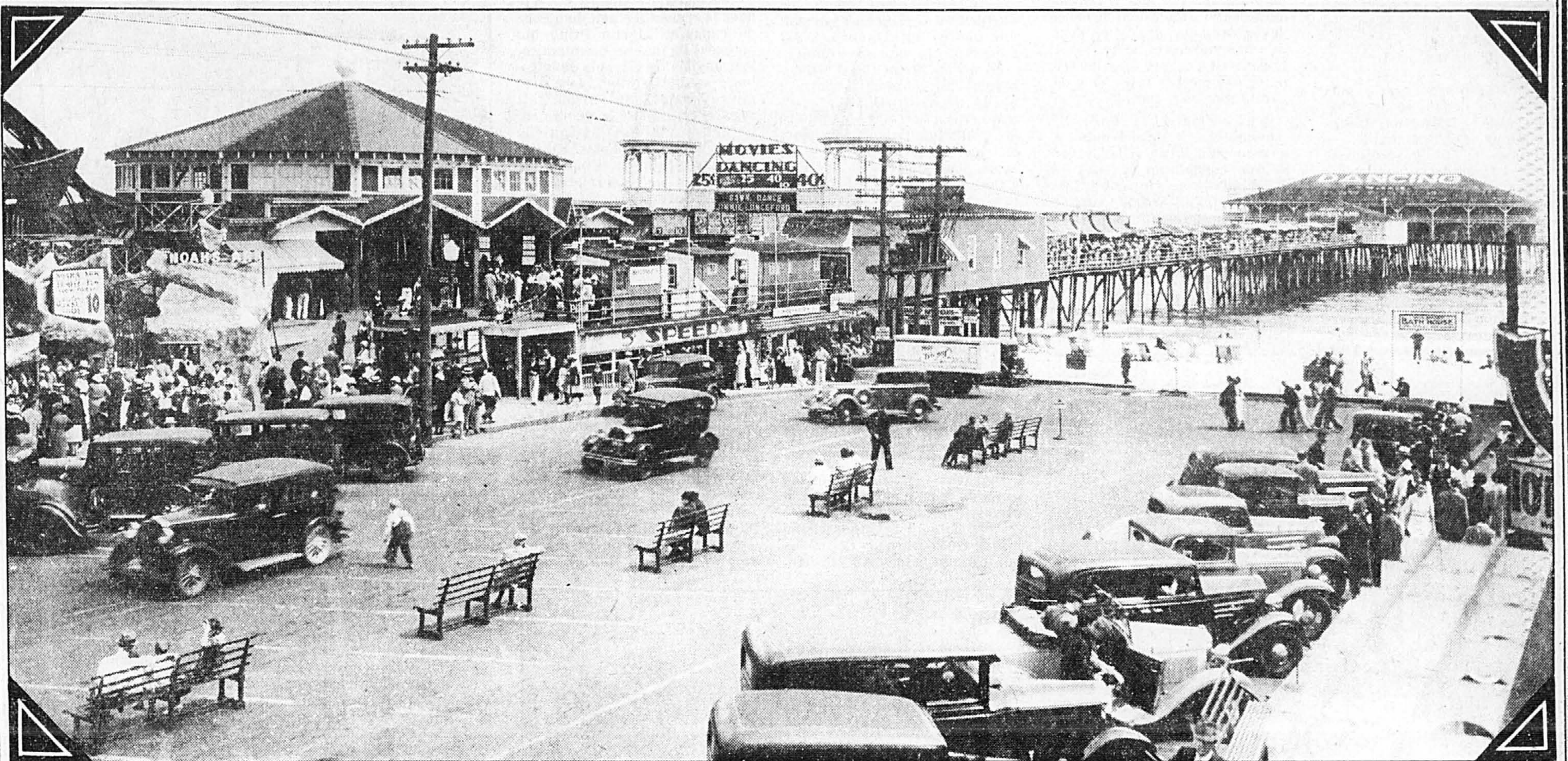
Au début des années '20, les couples se donnaient rendez-vous au Pier pour danser ou jouer au Casino.
