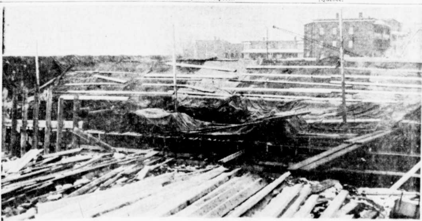
Bientôt fini — Il serait exagéré de parler du pont Montcalm sur son dernier mille, puisqu'il ne reste qu'une section de 12 pieds à couler. D'ici la fin de la semaine, le béton doit recouvrir la structure que l'on aperçoit au centre de la photo pour la relier à la rue King Ouest, qui apparaît au premier plan. (Photo La Tribune)
