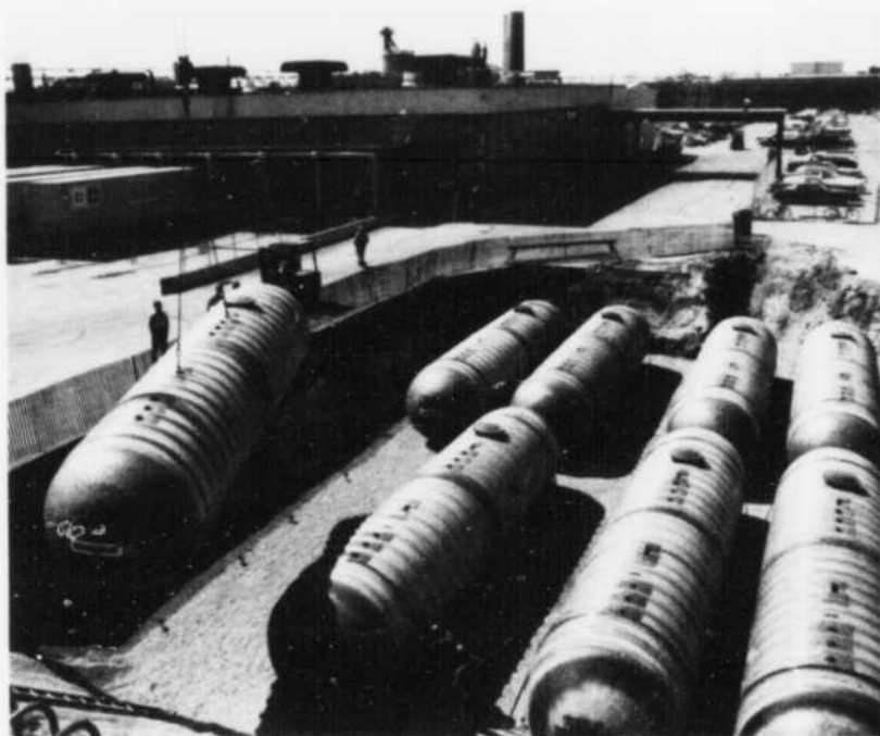
Installation de réservoirs en fibre de verre.
