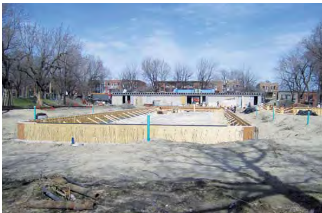
Chantier de la piscine Laurier en avril.
