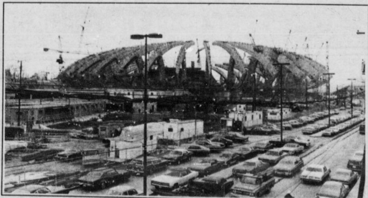
La masse de béton du chantier olympique sera la cause d'une série d'évé-
