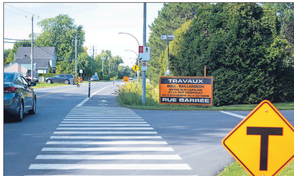
Les travaux sur la rue Baillargeon doivent se terminer vers le 25 septembre.
