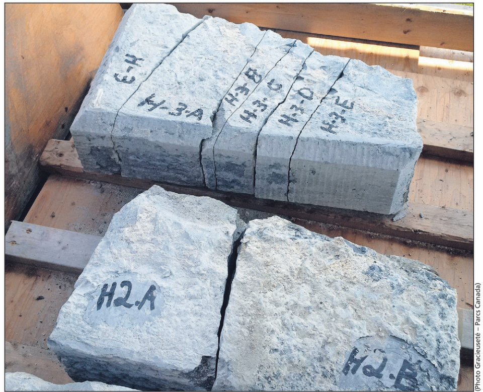
Afin de respecter l'intégrité du bâtiment, chaque pierre retirée était soigneusement identifiée et replacée au même endroit.
