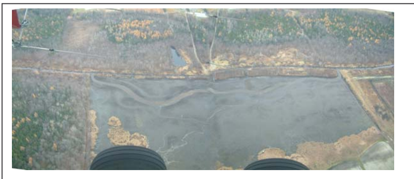
Mosaïque de 2 photos aériennes de l'étang en rive droite de la rivière Saint-Jean, en aval du barrage 3.
