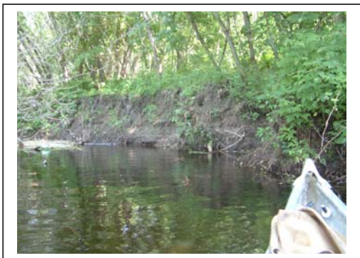
Exemple de berges arrachées
