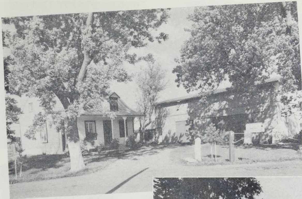
Ferme de M. Théodule Lahaie, Côte-Saint-Louis-des-Bouchards.
