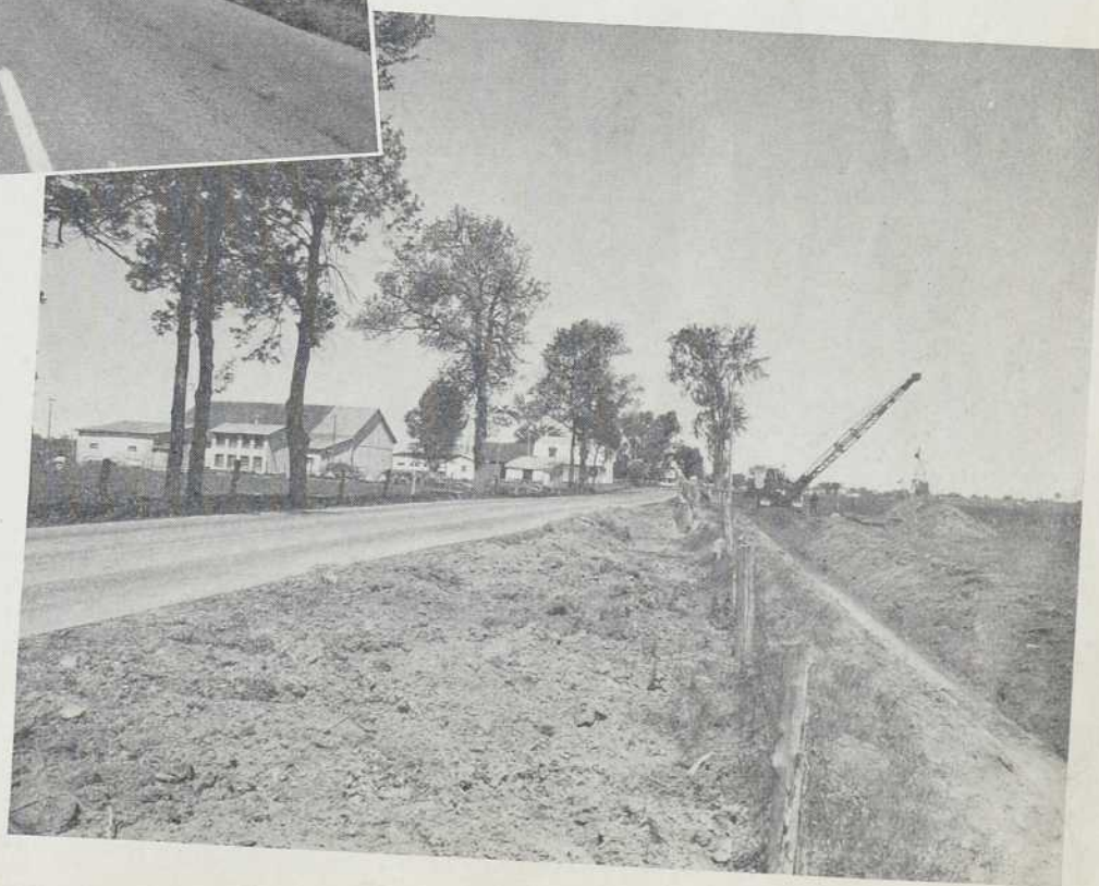
Creusage d'un cours d'eau dans Belle-Rivière pour permettre l'élargissement de la route No 8.
