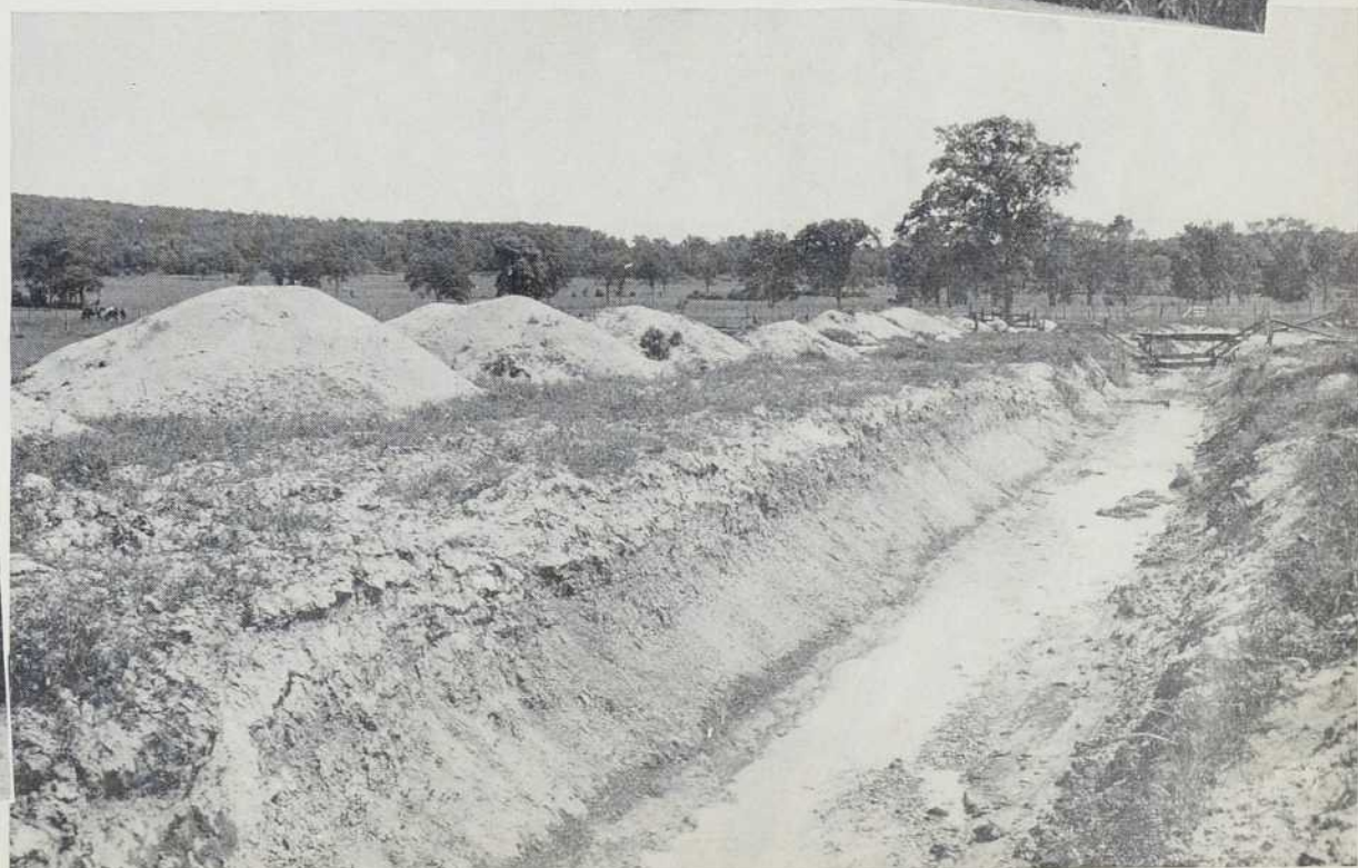
Deux sections du ruisseau Girard, à St-Placide, après le passage de la pelle mécanique.
