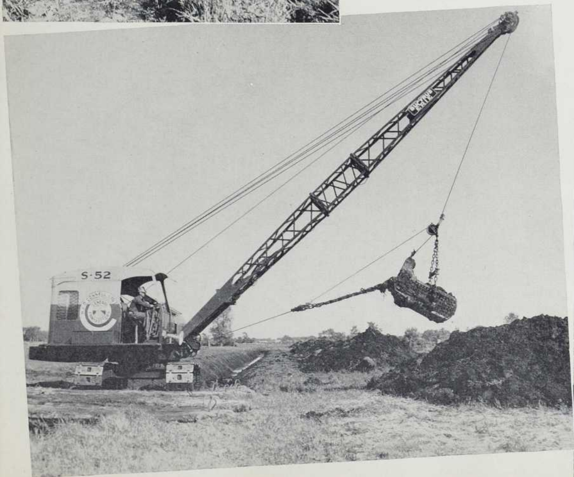
Pelle mécanique drainant le cours d'eau Archambault, dans Belle-Rivière: avant et après.
