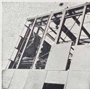
Panneaux de mur, type "sandwich", isolant et précoulé en voie d'installation dans un immeuble industriel moderne.
