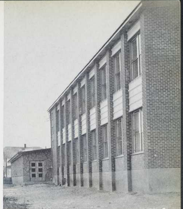
L'école, vue arrière. Même composition et projection de la salle dont la toiture est en pente.
