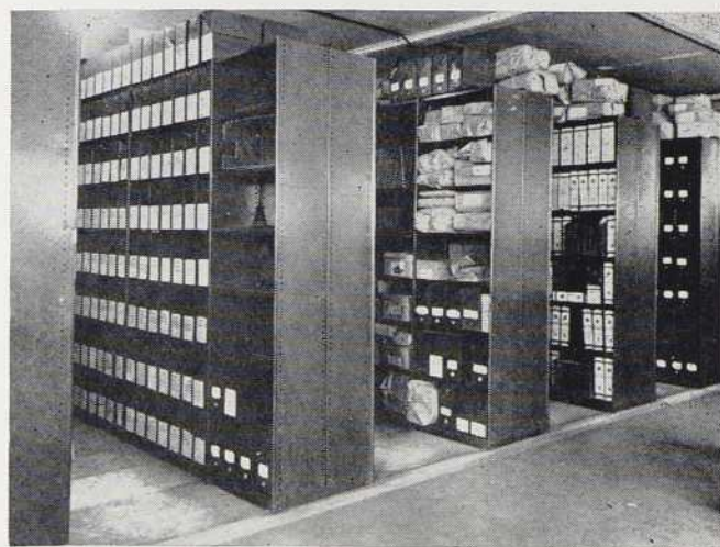
Installation de rayonnages en acier.
