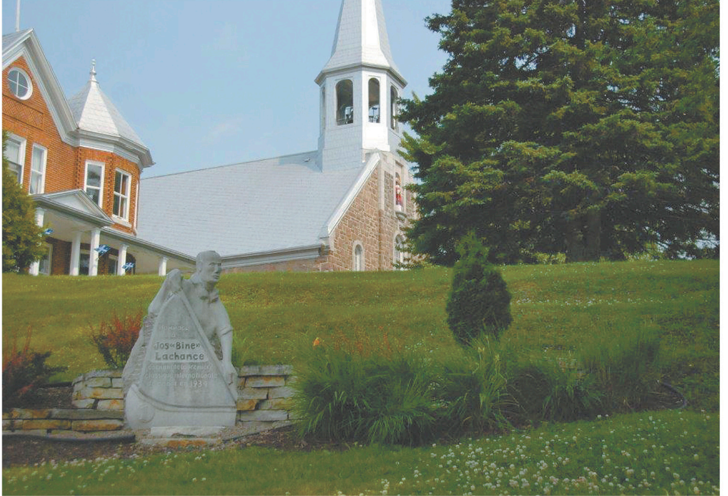
Le clocher de l'église de Saint-Élie-de-Caxton, prétexte à fierté pour le conteur Fred Pellerin : « Si t'as un beau clocher, tu vas te le shiner, le clocher ; c'est prétexte à rassemblements et à la collectivité. »
