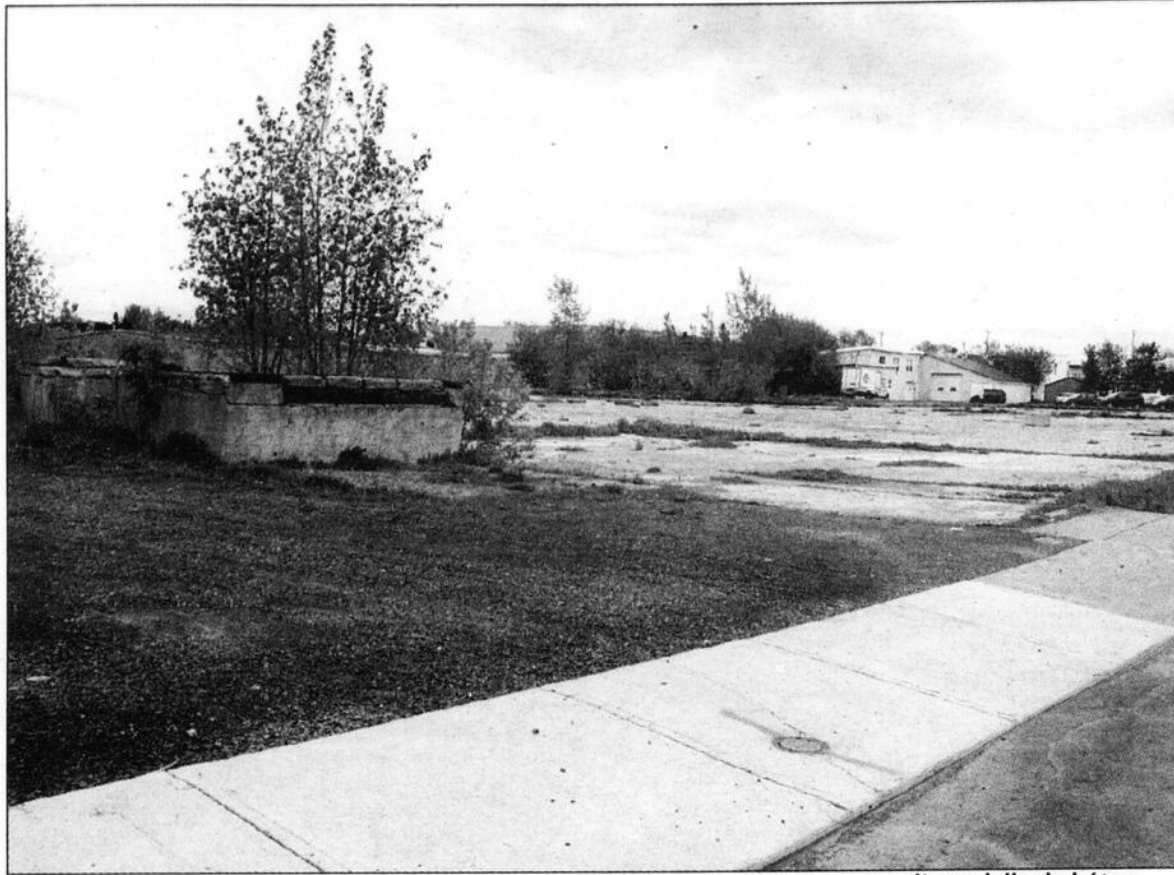
Une bonne partie du terrain d'une ancienne usine de batteries est recouvert d'une dalle de béton.
