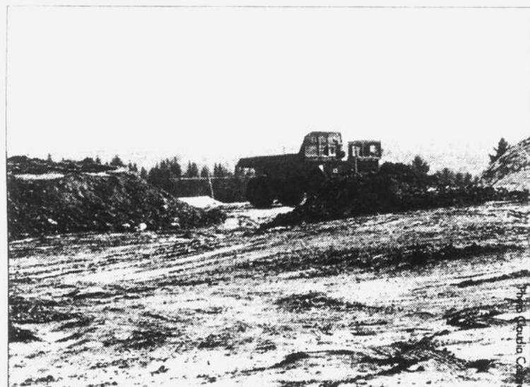
Les travaux sur le terrain qui accueillera le Wal-Mart ont débuté il y a deux semaines.
