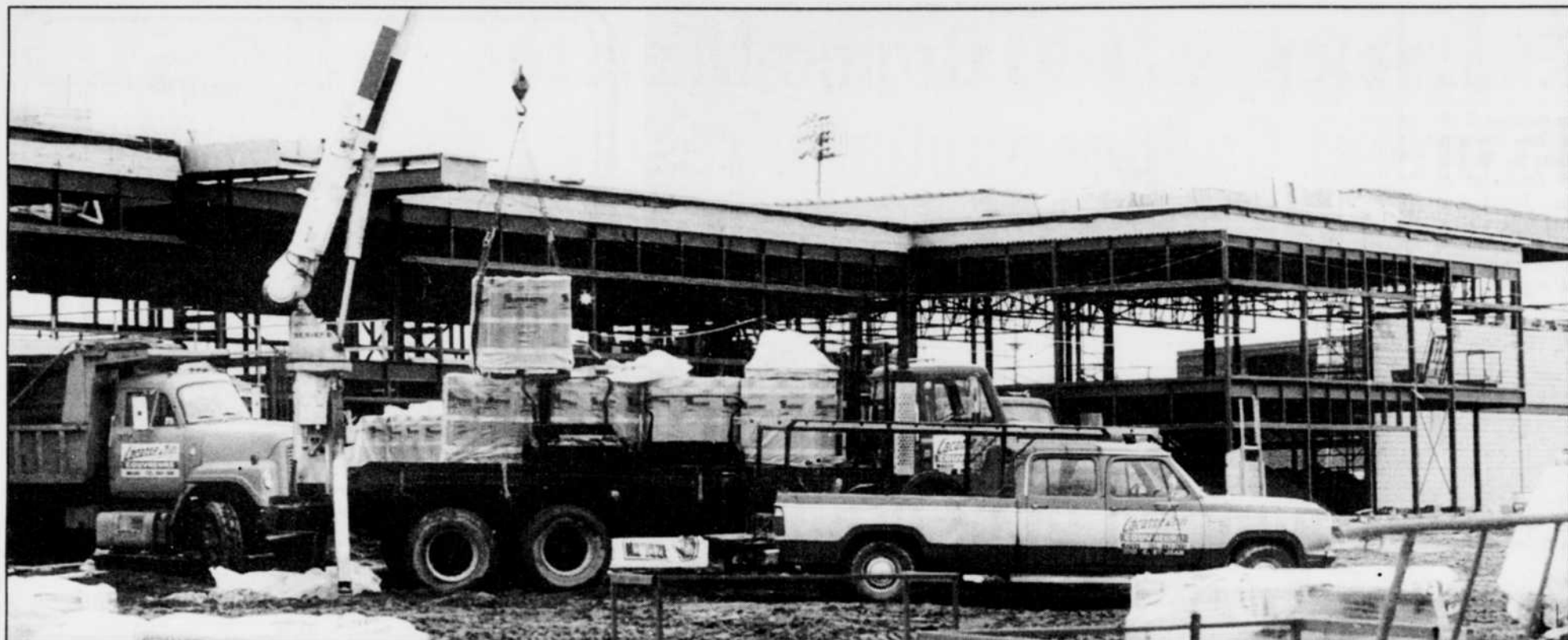
Cette photo a été prise sur l'un des rares chantiers en cours: celui de la nouvelle école secondaire du Canton de Granby.
