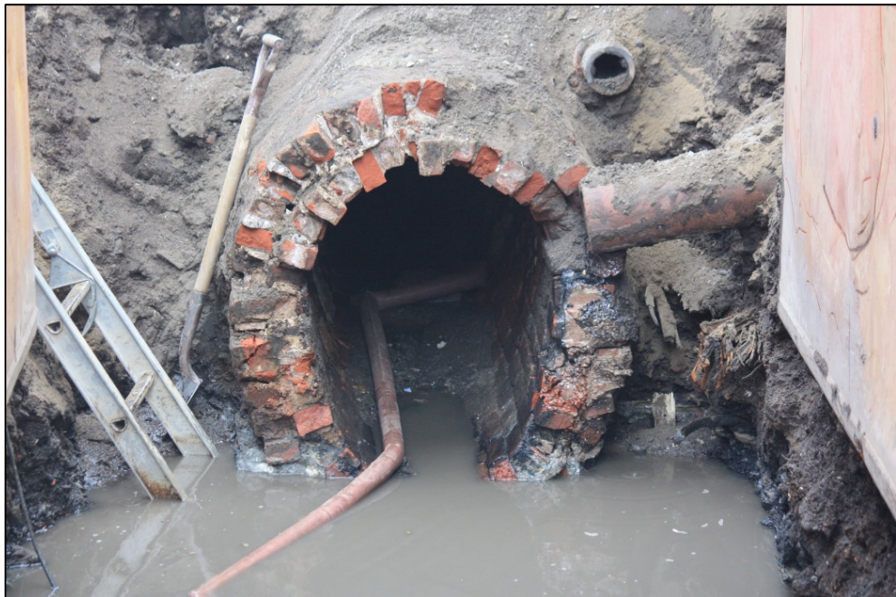
Photo 18. Ancienne conduite en brique mise au jour à l'extrémité nord du projet, vers le nord (RUR-VILLEQC-2013-031)
