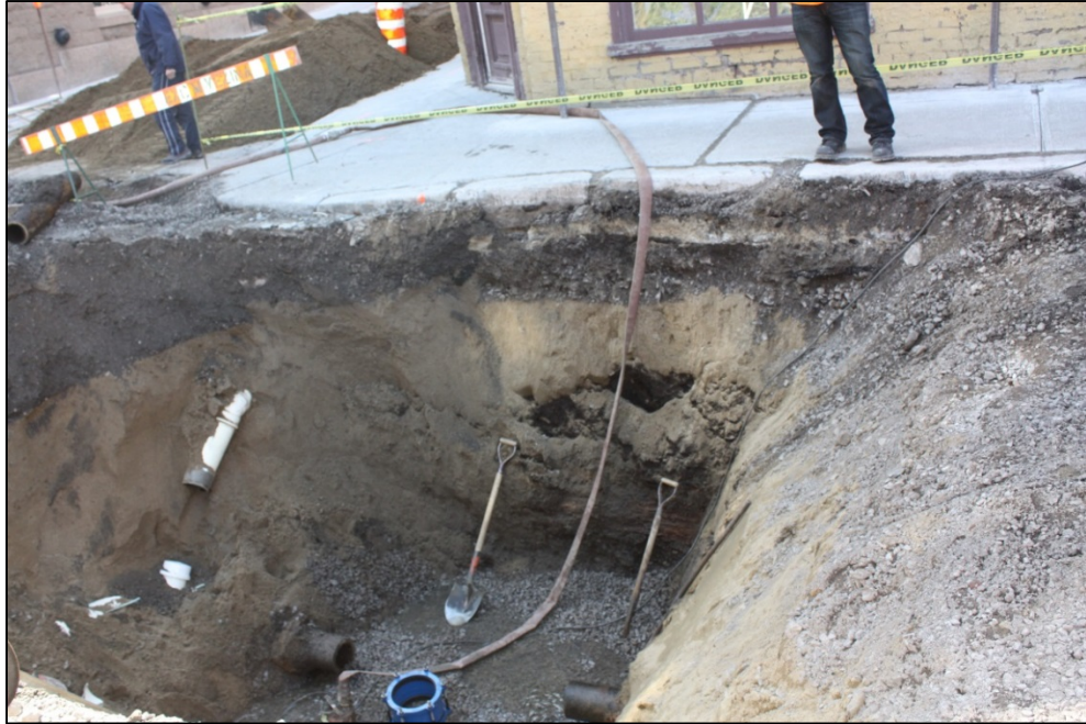
Photo 7. Paroi sud de la tranchée excavée dans la rue Saint-Paul, vers le sud (RUR-VILLEQC-2013-005)
