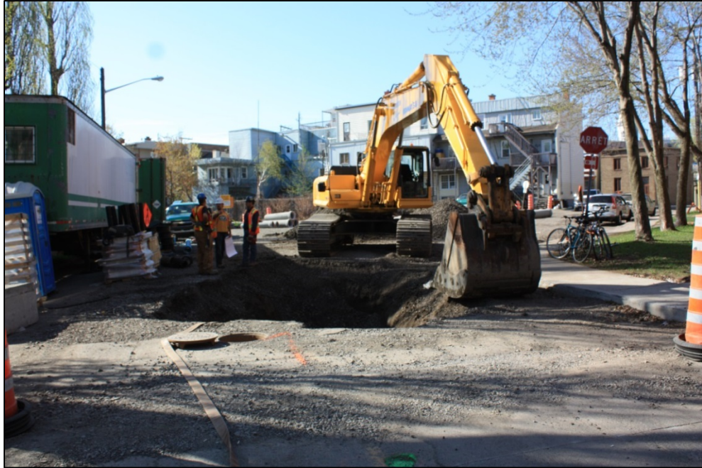
Photo 3. Vue de la portion ouest de la rue des Commissaires Ouest, vers le sud-sud-est (2013-CeEt-600-17A-047)
