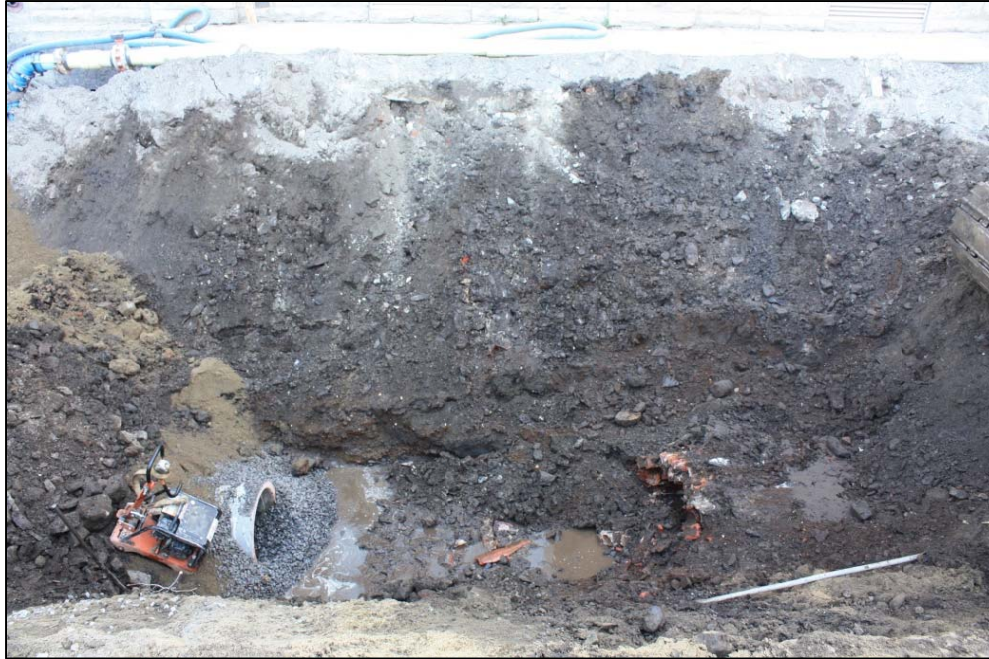
Photo 5. Paroi est de la tranchée excavée dans la portion centrale du projet, vers l'est (RUR-VILLEQC-2013-038)
