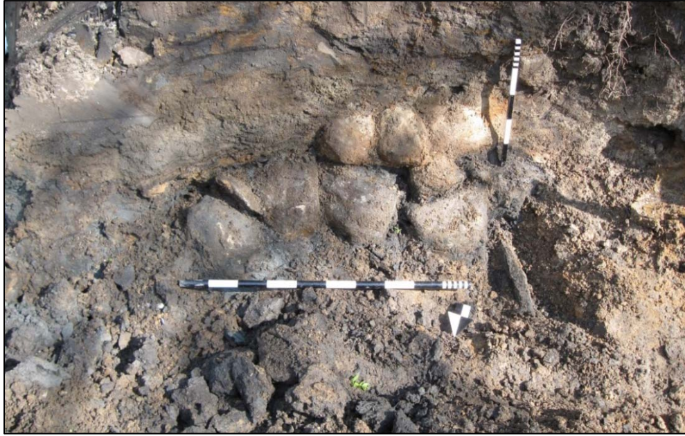
Photo 36. Vue en élévation du parement nord du vestige 17A400b (2013-CeEt-600-17A-122)
