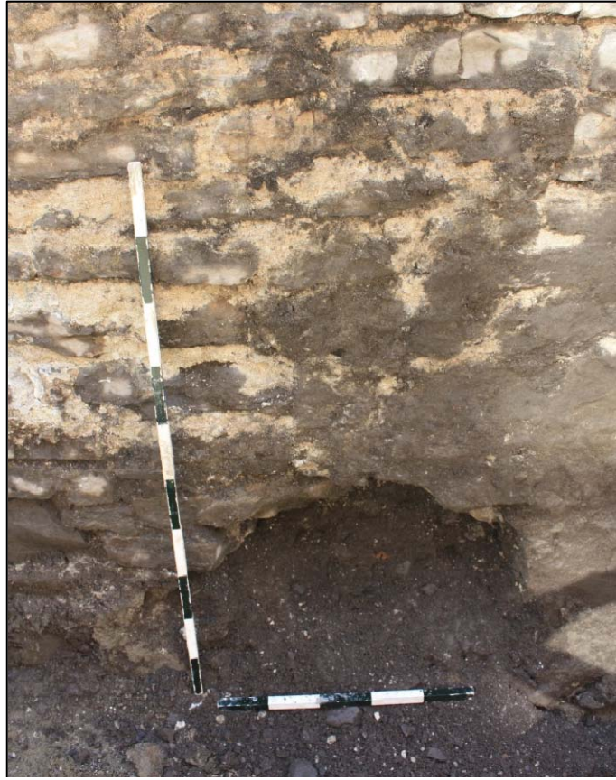
Photo 13. Détail de l'ouverture visible dans le parement est du vestige de maçonnerie en pierre 3A100 mis au jour dans la portion sud du projet, vers l'ouest (2013-CeEt-569-3A-007)
