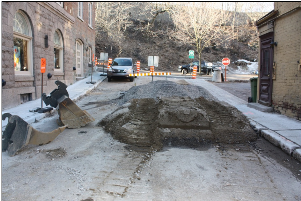
Photo 2. Vue de la portion sud de la rue Saint-Thomas, vers le sud-sud-est (RUR-VILLEQC-2013-001)
