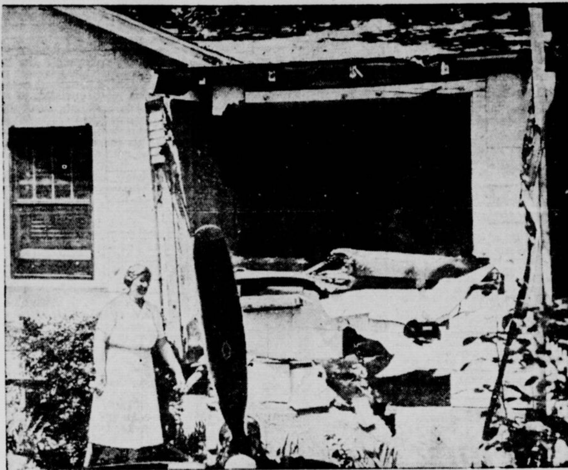
Pendant l'absence de Mme Swiger, à Merriam, Kansas, un Liberator, en s'écrasant, démolit l'avant et l'arrière de sa maison. Personne ne fut blessé gravement.
