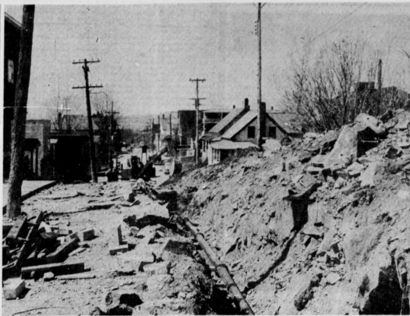
D'importants travaux à Windsor Mills. — Des travaux d'agrandissement sont actuellement en cours à Windsor Mills. Ces travaux furent entrepris après que le règlement autorisant un emprunt de $135,000 eut été adopté. C'est le contre-maître de la ville, M. Renaud Lemire qui dirige les opérations.
