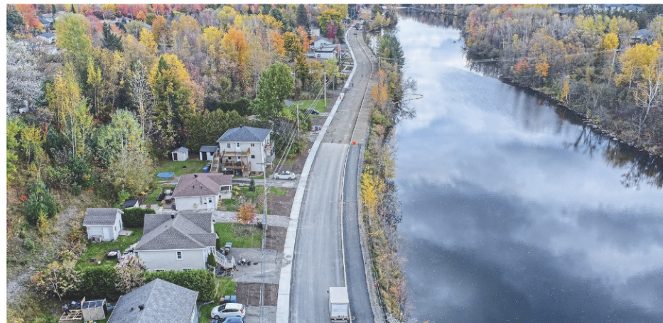
L'asphaltage progresse et devrait se terminer vers la mi-novembre sur la rue Saint-Patrice. Quelques autres travaux de finition seront toutefois nécessaires avant une réouverture complète au début du mois de décembre. (Photo gracieuseté - Bruno Paradis)
