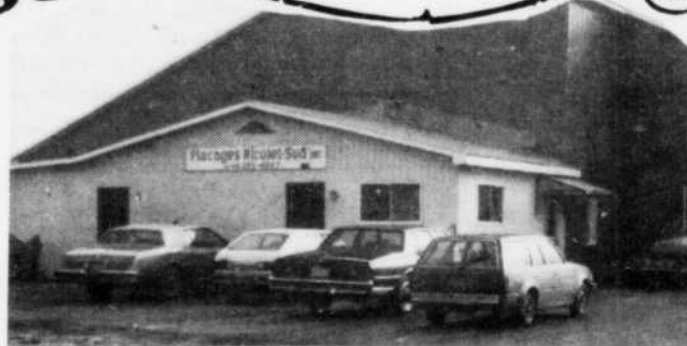
L'usine de Placages Nicolet-Sud est située sur la route Marie-Victorin. La sobriété de l'extérieur ne reflète pas l'activité intense à l'intérieur!
