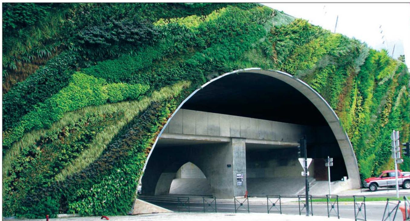
Le pont Max Juvénal à Aix-en-Provence, en France. Patrick Blanc habille des lieux tristes ou austères comme des ponts, des tunnels et des gares. — PHOTO PATRICK BLANC
