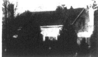
RIVIÈRE-DU-LOUP: (871) Rue Hayward: Joli cottage sur grand terrain intime, bien aménagé. Vue sur le fleuve et estuaire.
