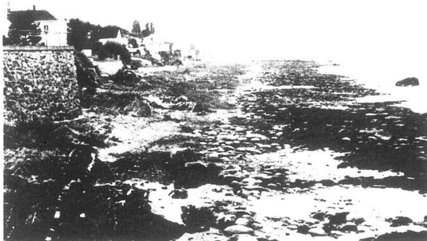
S'il est raccourci, le quai de Notre-Dame-du-Portage risque de moins protéger les berges.
