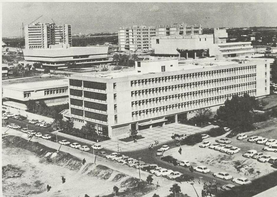
Vue de la façade Nord de l'Université de Tel-Aviv.
