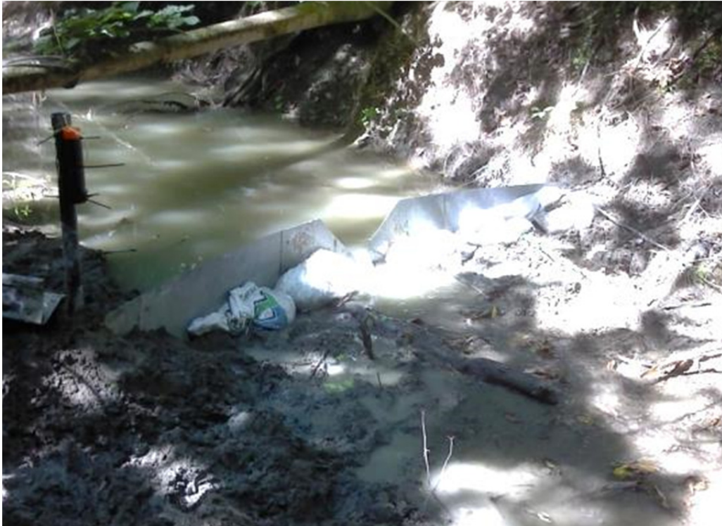
Figure 17 Barrage à encoche en V en amont du tronçon enroché sur le tributaire 5 de la rivière Salvail
