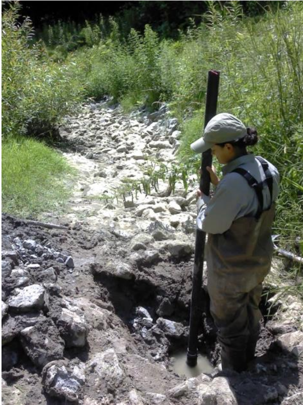
Figure 16 Installation d'un piézomètre dans le lit du cours d'eau
