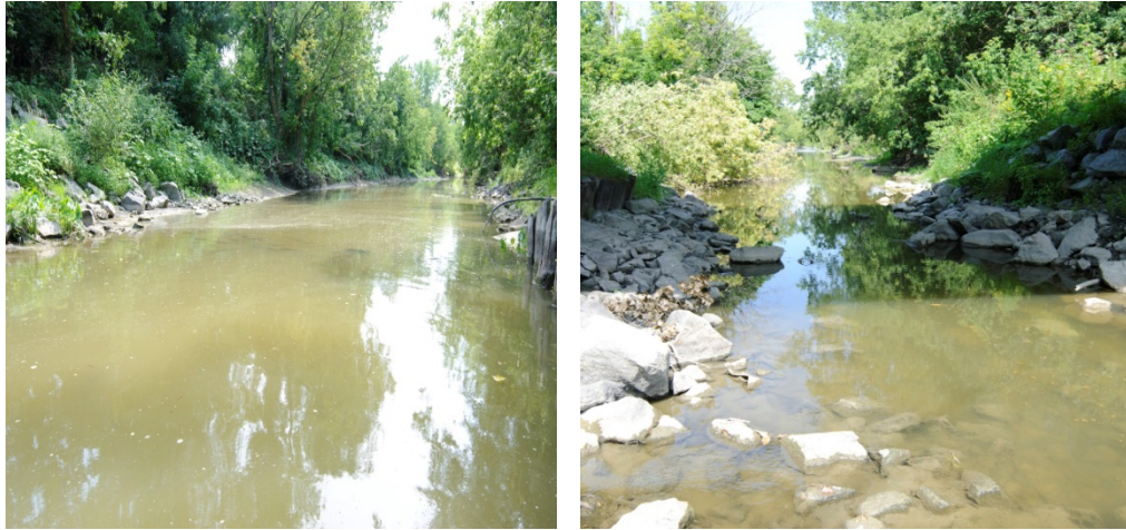
Figure 20 Exemple de site enroché (p16602), à droite, et son site non enroché de référence, à gauche, sur la rivière des Hurons
