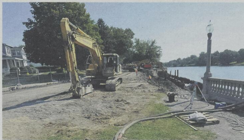
La Ville et son entrepreneur général n'évaluent pas de la même façon le coût réel du prolongement du mur de la terrasse Louis-Côté, à l'été 2013.
