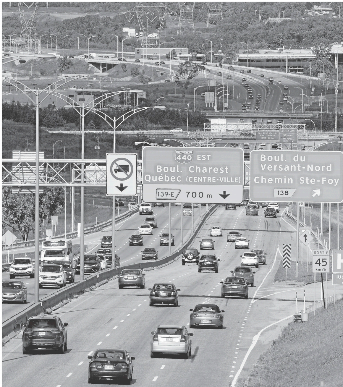
On peut vouloir corriger des anomalies du réseau autoroutier et remplacer les ponts de béton qui s'effritent, comme on s'appête à faire sur l'autoroute Henri-IV, mais on a l'impression que ces travaux tiennent davantage d'une stratégie d'élargissement des autoroutes, déplore notre chroniqueur. — PHOTOTHÈQUE LE SOLEIL, ERICK LABBÉ
