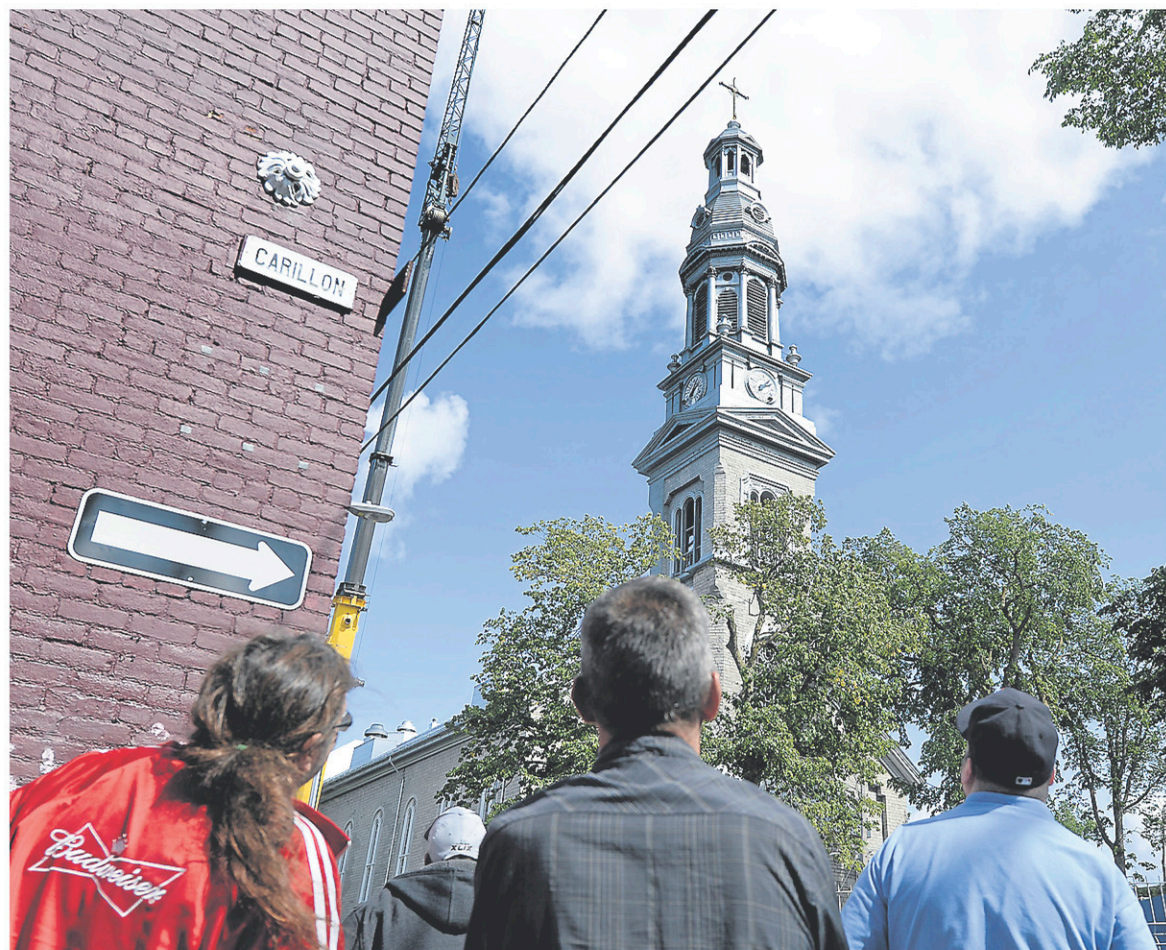
Le Service de protection contre les incendies a érigé un périmètre de sécurité en début de semaine (la rue Boisseau et l'avenue des Oblats sont fermées) et les pompiers ont interdit aux enfants de l'école voisine de sortir pour la récréation depuis la rentrée scolaire. — PHOTO LE SOLEIL, YAN DOUBLET
