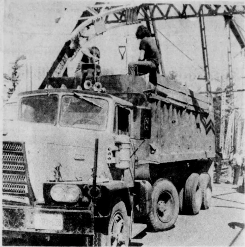
On a dû décharger ce lourd camion chargé de pierre à la pelle avant qu'il ne puisse être remorqué. Le pont aurait subi des dommages de l'ordre de $5,000 qui ont nécessité la fermeture et l'ouverture prématurée du nouveau pont de la rue St-Georges. (Photo La Tribune Drummondville)
