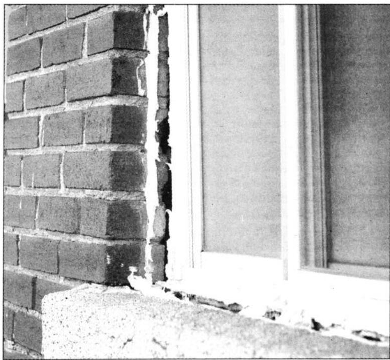
Le mur de brique bombé s'est détaché du châssis de cette fenêtre.
