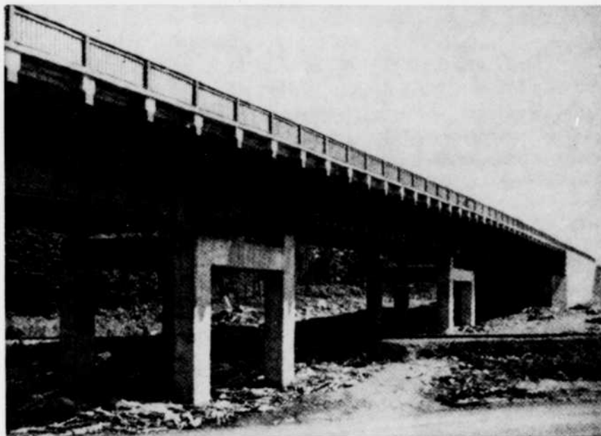
Structure du viaduc au-dessus des voies du C.N.R. sur l'Autoroute Montréal-Laurentides à St-Jérôme
