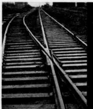
Traverses traitées à l'OSMOSE en 1938 et encore en usage
