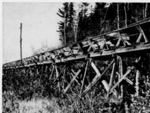
Poteaux de garde-fou traités à l'OSMOSE en 1943 et encore en usage
