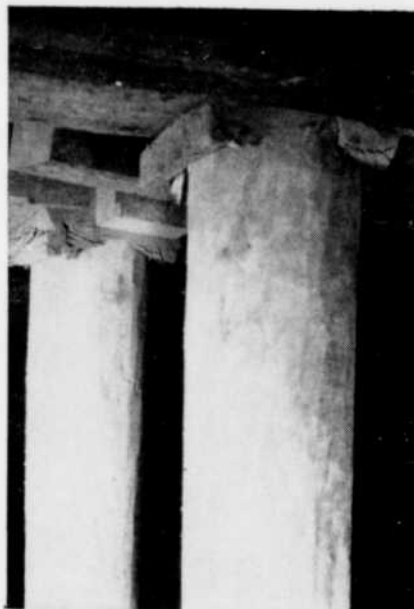
Bois de mine traité à l'OSMOSE en 1936
