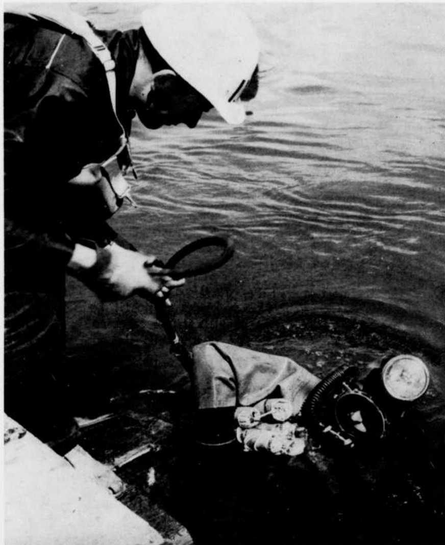
Fig. 3 — Un plongeur descend placer une charge de dynamite à l'endroit désigné après étude des plans du bateau.
