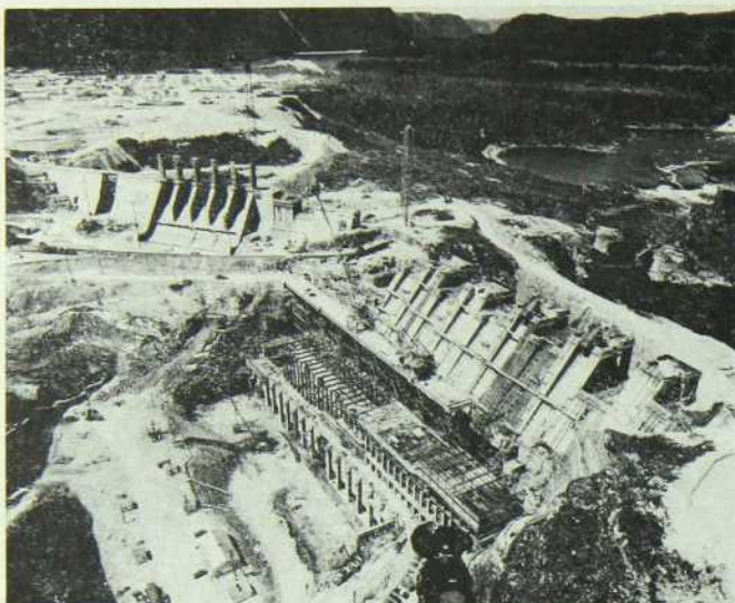
Les travaux à Manic 2, vus sous un autre angle.
